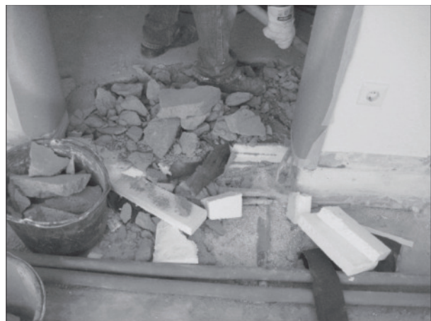
Bild 1: Desinfektion von Estrichdämmungen erspart teuren Rückbau
