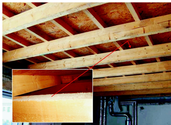
Die Reinigung auf der Oberseite der Sparren wurde übersehen. Dies führte zu dem zuerst schlechten Sanierungsergebnis.
