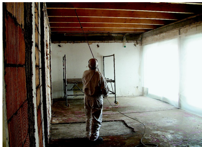
Mit Hilfe der Sprühlanze wurden die Oberflächen im Deckenbereich mit Schimmelpilz-Entferner entkeimt.
