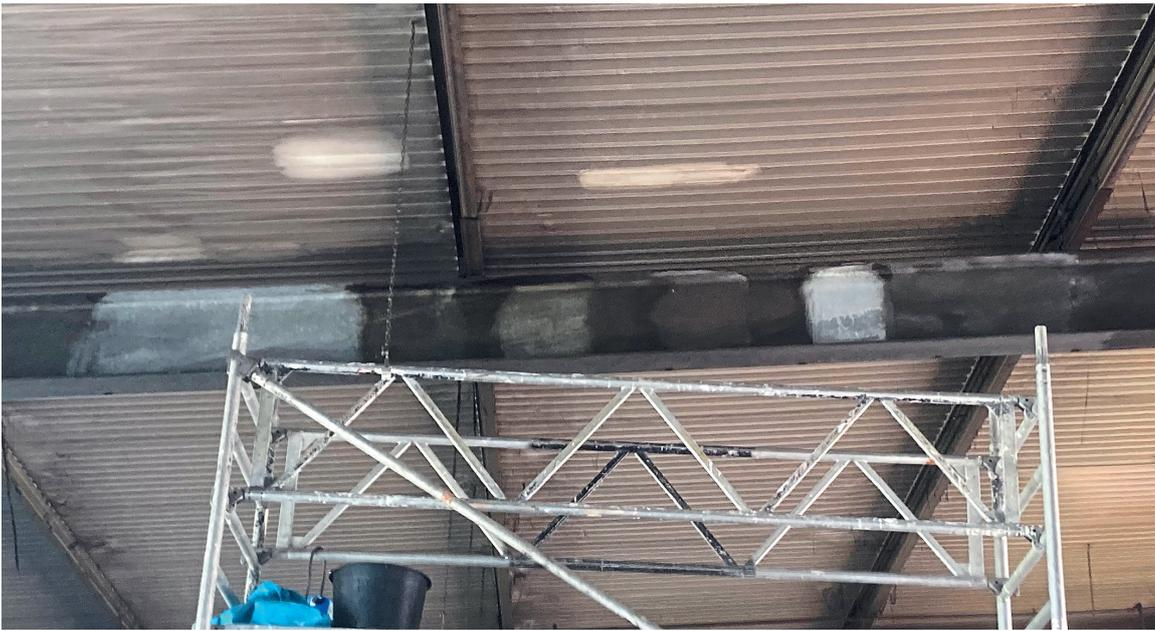
Reinigungsversuche an einem kontaminierten Stahl-/Zinkträger mit unterschiedlichen Reinigern (v.li.): mittelalkalischem Reiniger (pH-Wert 13) in Anwendungskonzentration 1:4; mittelalkalischer Reiniger (pH-Wert 12) in Konzentration 1:4; Neutralreiniger (pH-Wert 7) in Konzentration 1:9; hochalkalischer Reiniger (pH-Wert 14) in Konzentration 1:5.
