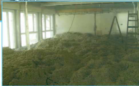
Dämmung aus der Decke.
