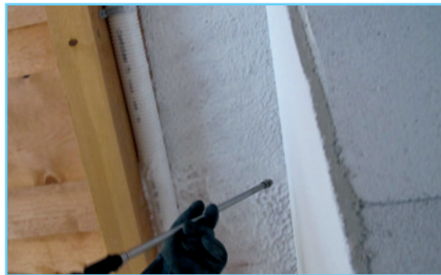
Behandlung mit JATI DACHSTUHL-SCHAUM.
