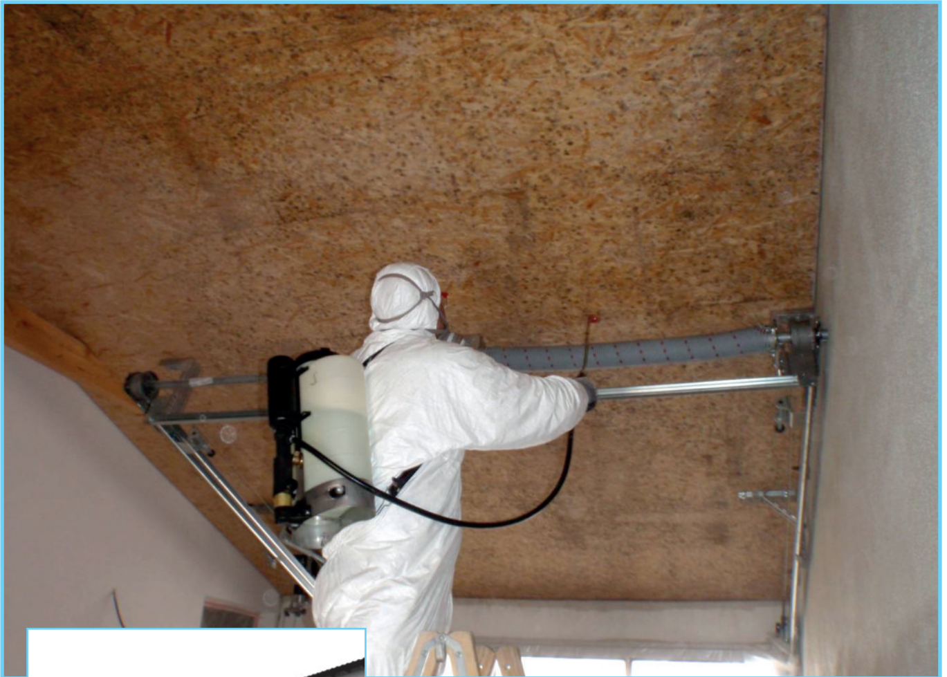
Behandlung der OSB-Platten mit JATI SCHIMMELPILZ-ENTFERNER.
