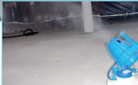
Als abschließende Maßnahme wurde nach einer gründlichen Feinreinigung JATI SPOREN-VERNICHTER in der Cafeteria vernebelt.
