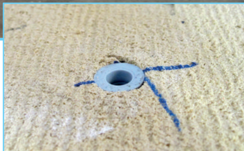
12 mm Bohrung mit Packer.
