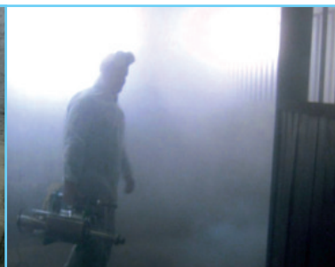
Nach der Feinreinigung erfolgte zum Abschluss der Sanierung die Vernebelung von JATI SPOREN-VERNICHTER.
