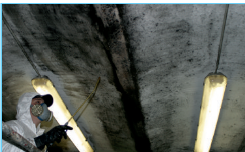
Behandlung der mit Schimmelpilz befallenen Stalldecken.
