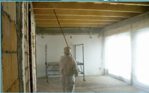
Unbedingt zu bedenken und nicht zu vernachlässigen war hier die Feinreinigung auf den Kehlbalcken!
