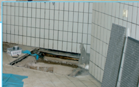
Versorgungsschächte im Bodenbereich erforderten eine besondere Qualität der Desinfektionsvorbereitung, um ein unkontrolliertes Abfließen der JATI ESTRICHDÄMM-DESINFEKTION zu verhindern.
